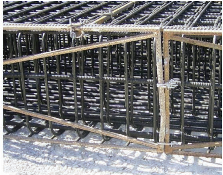
Resim 4. Detaylı GFRP donatı detayları duvar kazık ve diyafram duvarı (çelik destek elemanı ile birlikte)
