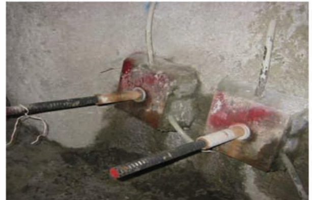
Resim 6. Singapur'daki kazıyı sabitlemek için lokal olarak kullanılan öngerilimli GFRP ankrajları
