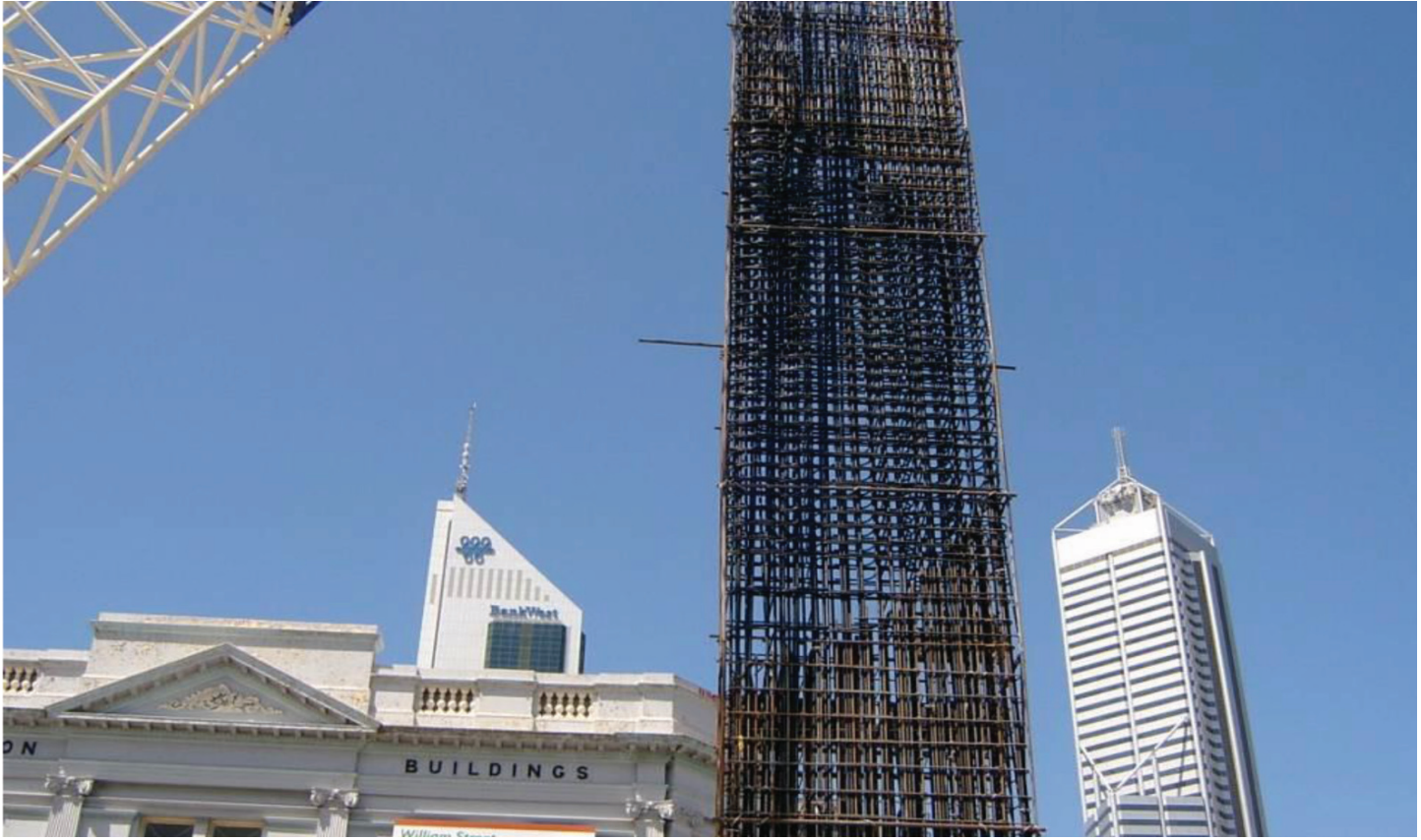
Resim 3. Perth, Avustralya'daki Yeni Metro Hattı Projesindeki diyafram duvarının Soft-Eye donatısı.
