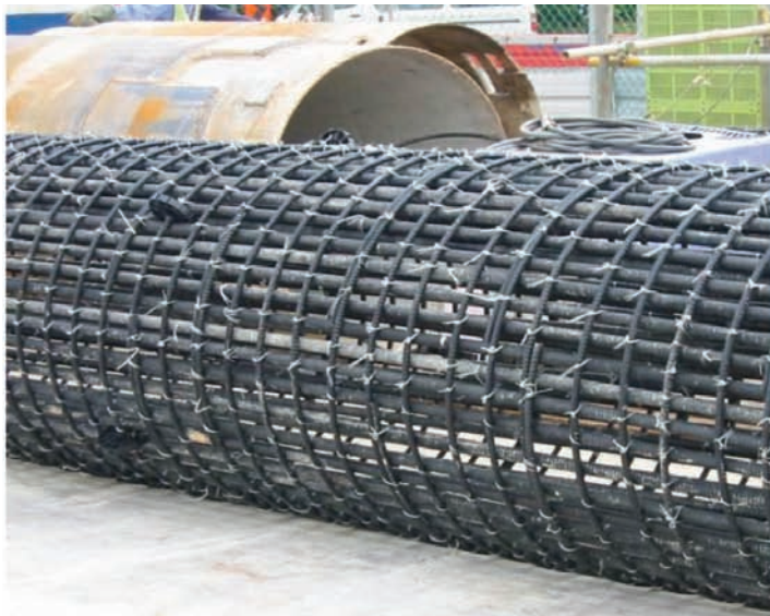
Resim 4. Detaylı GFRP donatı detayları duvar kazık ve diyafram duvarı (çelik destek elemanı ile birlikte)
